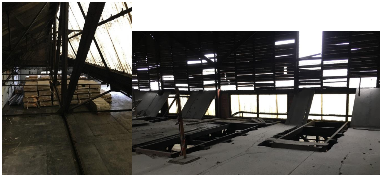
PHOTO 3 : MISE A L'AIR LIBRE DE LA ZONE DE TRIAGE
