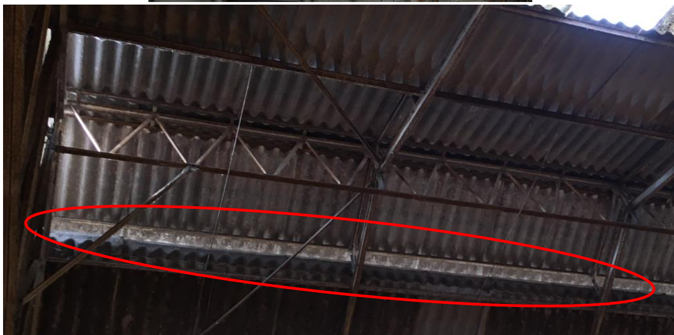
PHOTO 4 : DISPOSITIF DE MISE A L'AIR LIBRE DU FAITAGE DU BATIMENT ECORÇAGE
